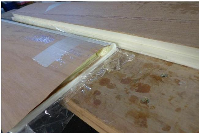
La colle PU s'expande au séchage, c'est pourquoi il faut bien protéger les éléments qui ne doivent pas être collés
